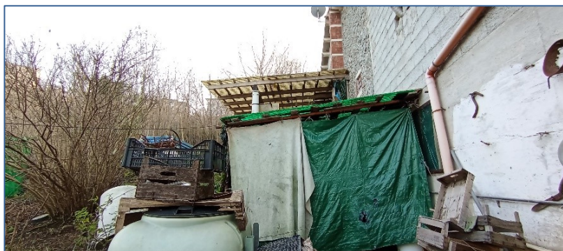
Baraccamenti lato est
