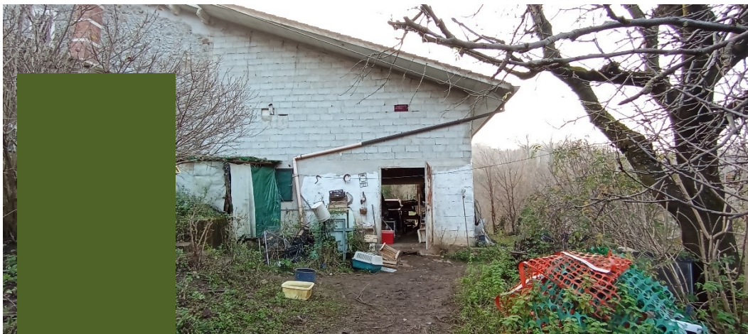
Magazzino prosp. est
