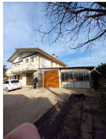
VISTA ESTERNA TETTOIA
