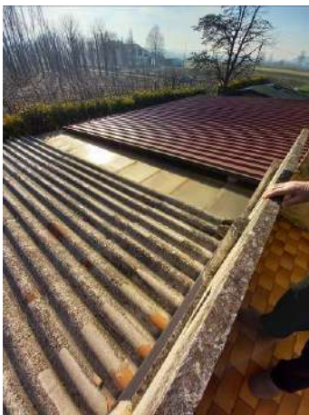
VISTA COPERTURA TETTOIA
