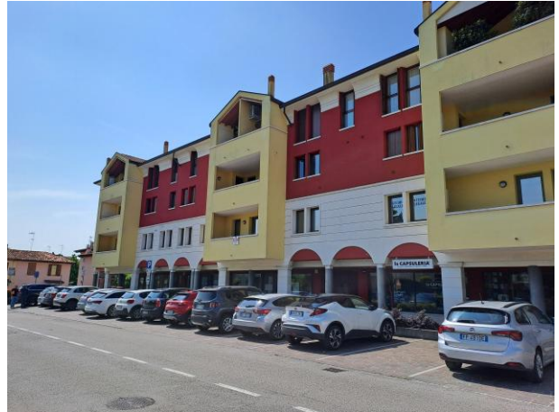
Vista generale da Nord-Ovest
