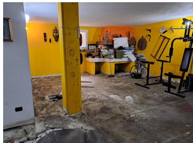
Vista del ripostiglio interrato
