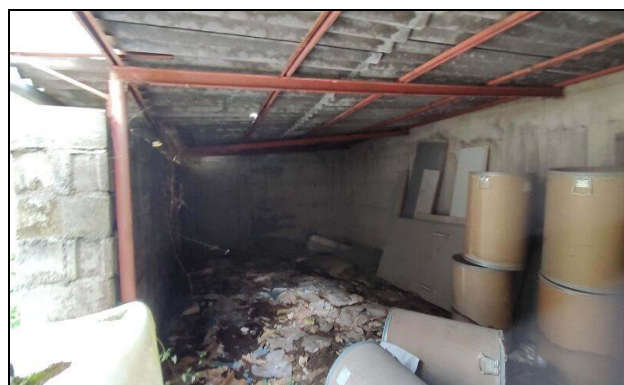
Vista deposito a confine nord-est
