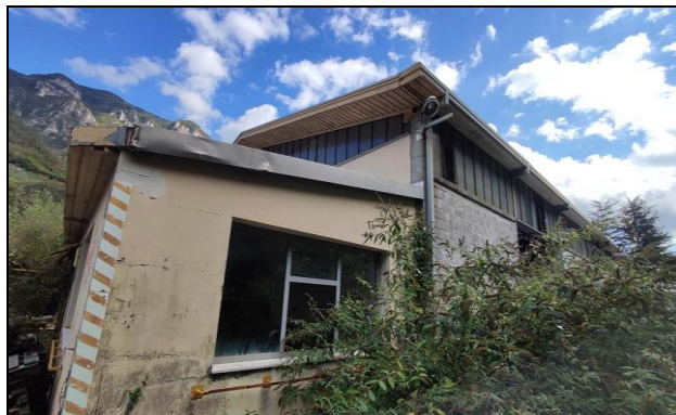
Vista angolo nord-ovest
