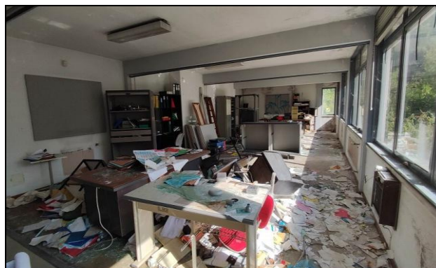
Vista interna degli uffici piano primo
