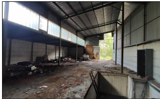
Vista interna immobile F
