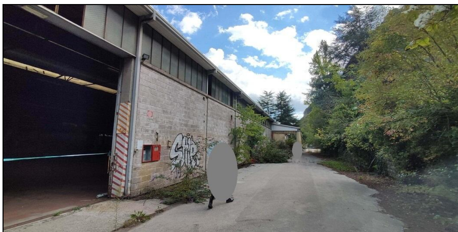
Lato ovest con ingresso al capannone
