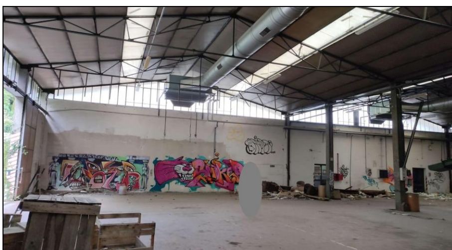
Vista interna capannone
