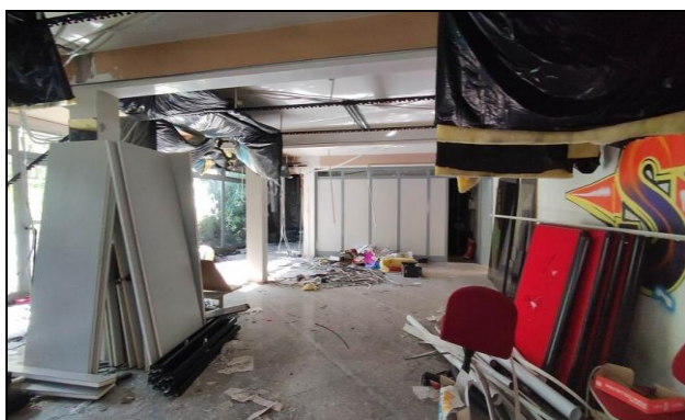
Vista interna degli uffici piano terra
