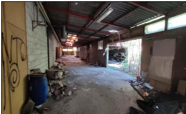
Vista immobile D – officina
