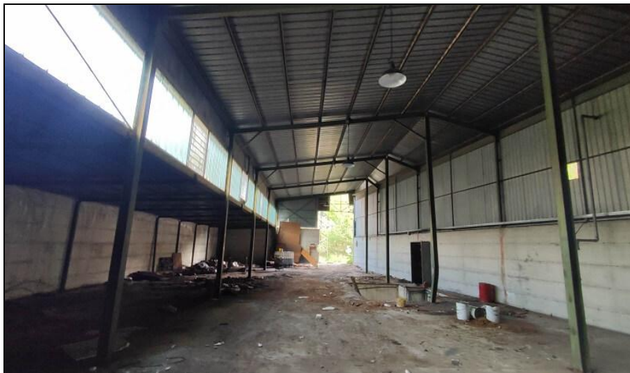
Vista interna parte principale dell'immobile F
