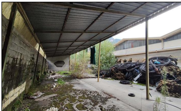
Tettoia confine nord-ovest
