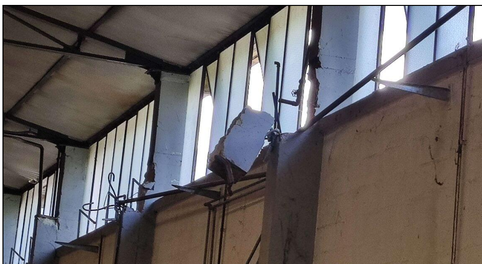
Pari dei pilastri demoliti per asportazione carroponte
