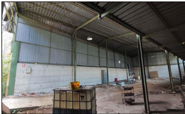
Vista interna immobile F
