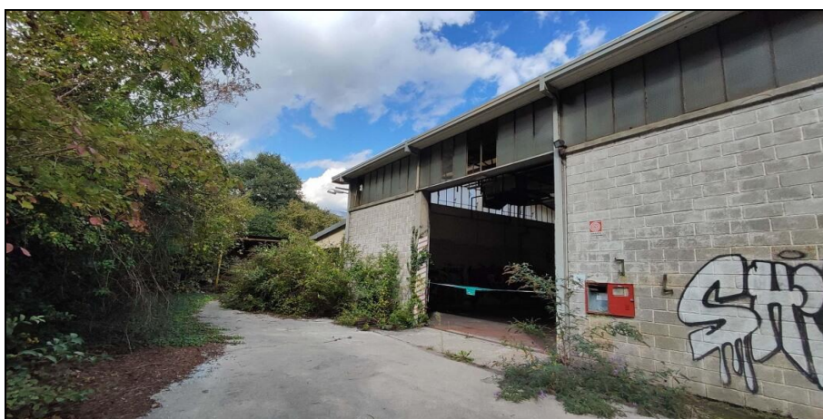
Lato ovest con ingresso al capannone
