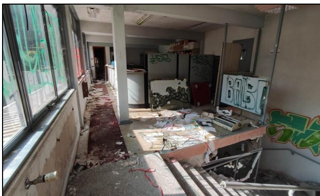
Vista interna degli uffici piano primo
