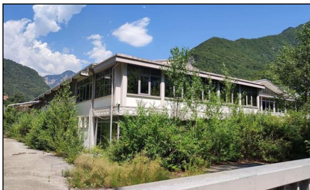
Vista esterna degli uffici – lato sud
