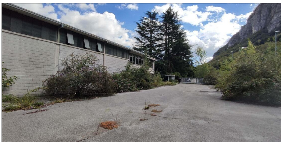
Vista facciata lato ovest
