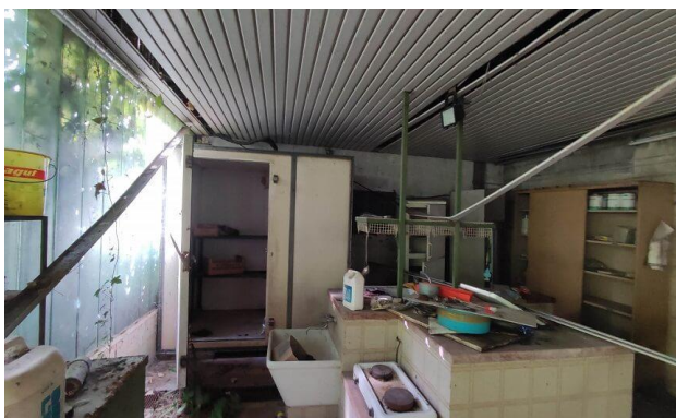
Tettoia precaria lato sud-est
