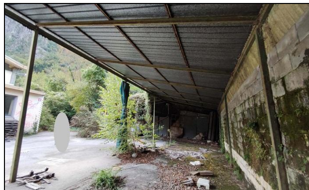
Tettoia confine nord-ovest
