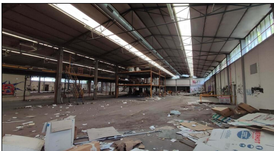
Vista interna capannone - soppalco
