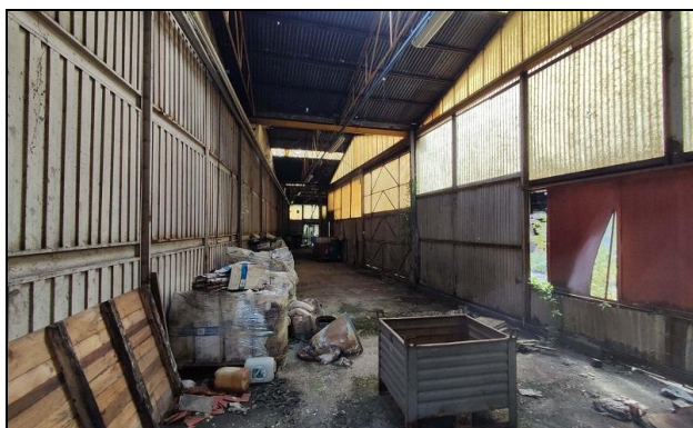
Vista interna immobile E – con rifiuti abbandonati
