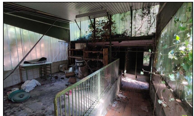
Tettoia precaria lato sud-est
