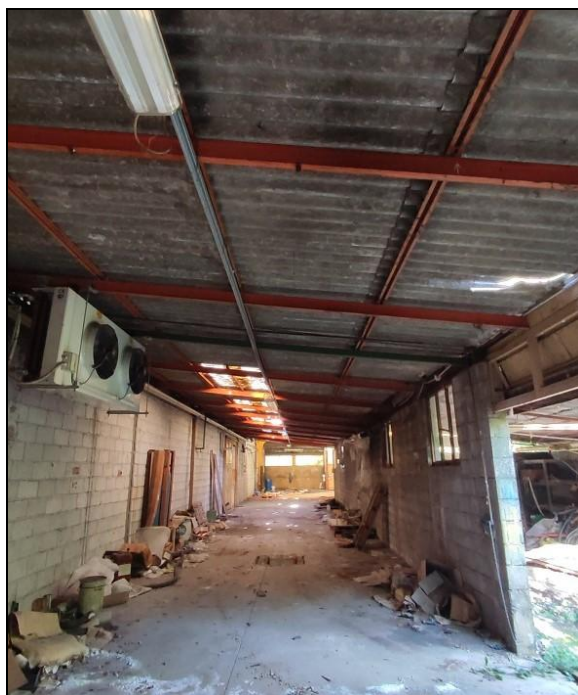
Vista immobile D – officina
