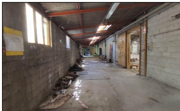
Vista immobile D – officina
