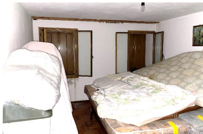
Vista della camera al piano primo
