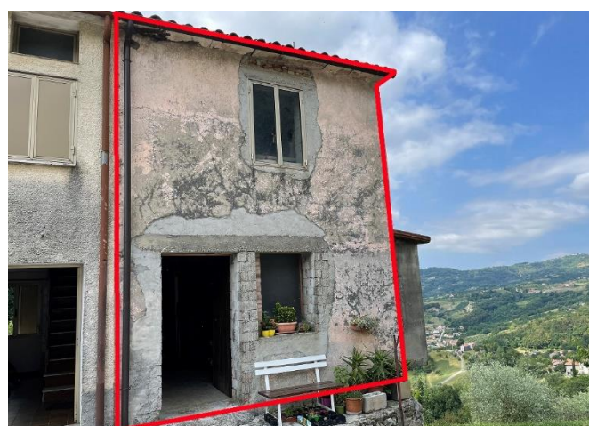
Vista dalla strada dell'abitazione rurale di testa
