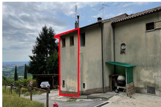
Vista dell'abitazione di testa del fabbricato rurale
