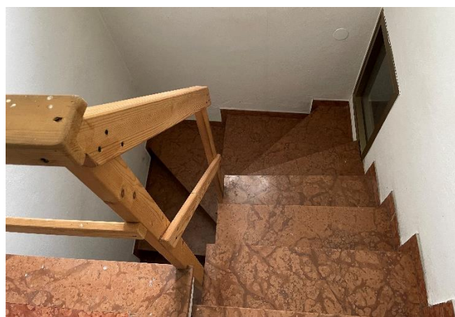
Vista della scala in muratura
