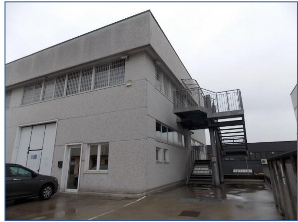
Scala d'accesso al p. 1° (lato Ovest)
