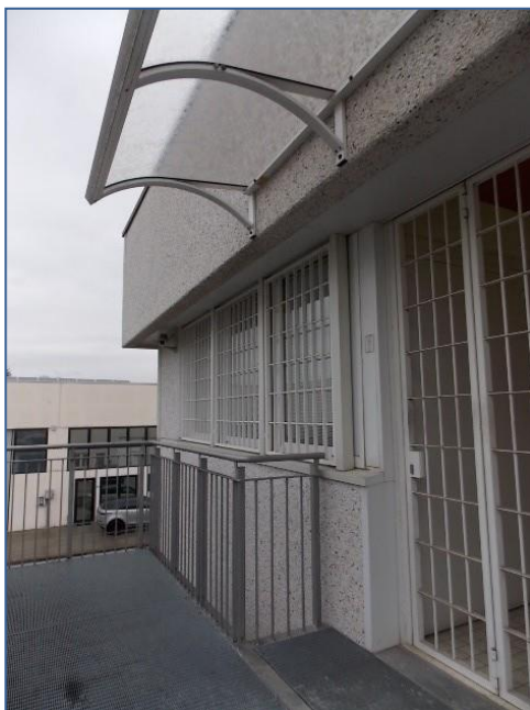
Pianerottolo scala piano primo
