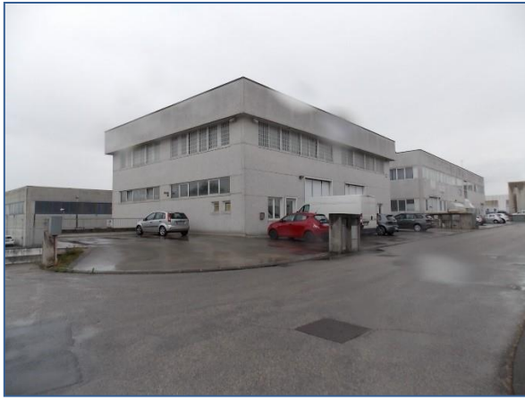
Vista da N/E con area di corte (parcheggio)
