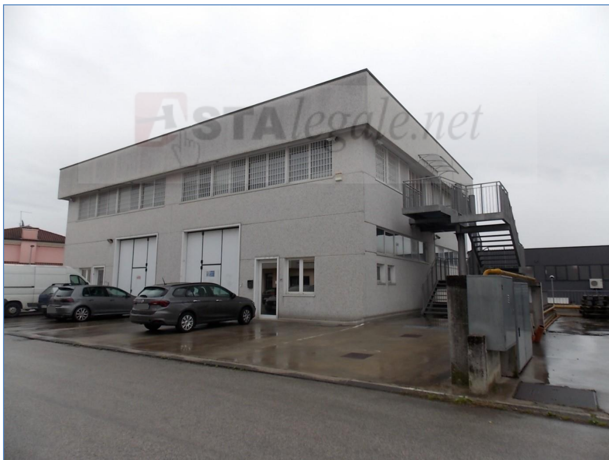
L'edificio in via San L. Murialdo, n° 51 – la procedura interessa le due unità al piano primo e le parti millesimali di comproprietà del fabbricato (scala/ingresso a p. T, 1° e corte a p.T sui lati N, E, O)
