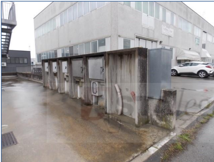
Contatori delle unità edilizie
